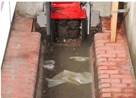
**Bild 1:** Die Ripper-Rotoren zerkleinern Störstoffe im Abwasser.
