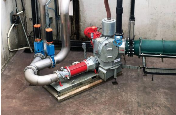
Bild 1: Der universelle Feststoffdosierer PreMix maischt unterschiedliche Substrate zu einer homogenen Biosuspension an.
