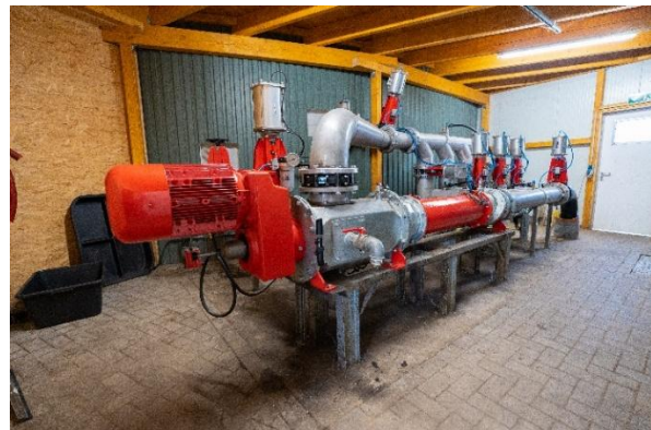
Bild 4: Die konische Exzentrerschneckenpumpe HiCone zeichnet sich als Einzellösung (im Bild als Zuführpumpe zum Flüssigfütterungssystem) und Bestandteil der MixXPump sowie des PreMix Flüssigfütterungssystems durch hohe Energieeffizienz, lange Standzeiten und reduzierte Lebenszykluskosten aus.
