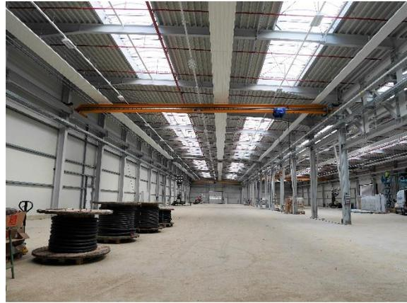
**Bild 2:** Nachhaltige Fertigung: Lichtbänder sorgen für ein angenehmes Raumklima und sparen Energie ein.
